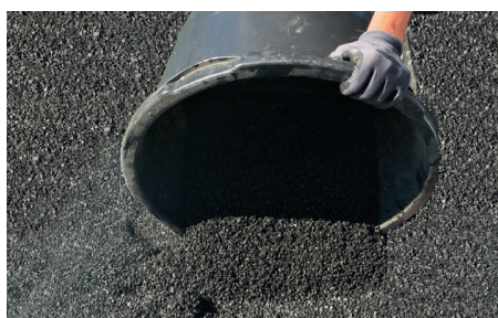
se aplică splitul adăugat prin amestecare pe stratul portant
