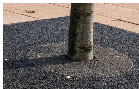
strat de acoperire în stare finită
